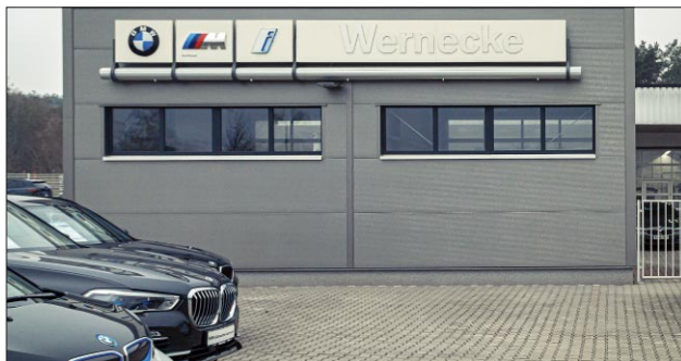
■ In den neuen Hallen erfolgt die Fahrzeugaufbereitung.
