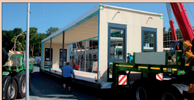
■ Die Teilstücke für die neue Kita kamen mit Schwertransportern.
